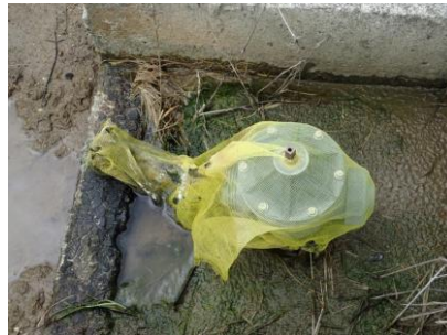
図7 取水口の侵入防止網
