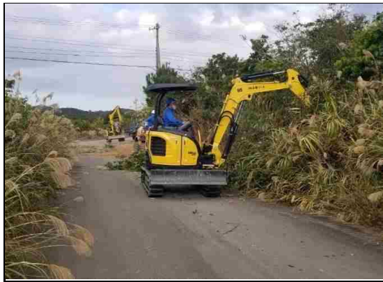
土地改良区幹線道路 ユンボで伐採
