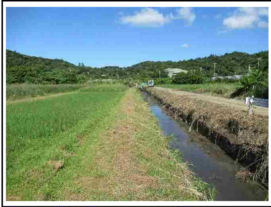
(草刈り／排水路土砂撤去完了)
