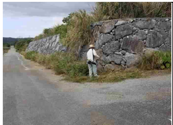
草刈り機で除草作業
