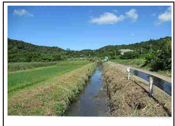
(草刈り／排水路土砂撤去完了)
