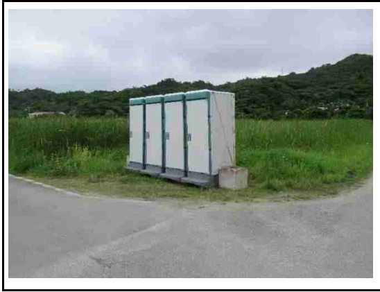
(オクラレルカ／仮設トイレ設置)
