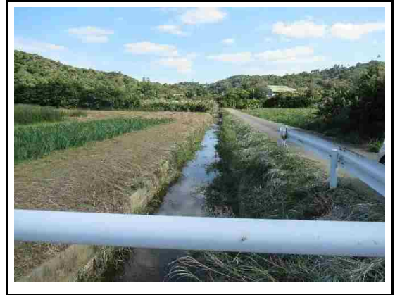
(草刈り／排水路土砂撤去完了)
