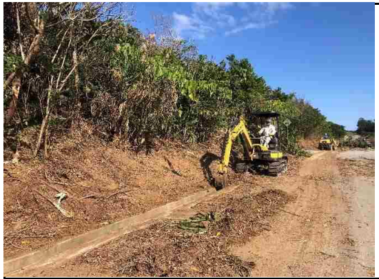
19号農道側溝の土砂等の除去作業
