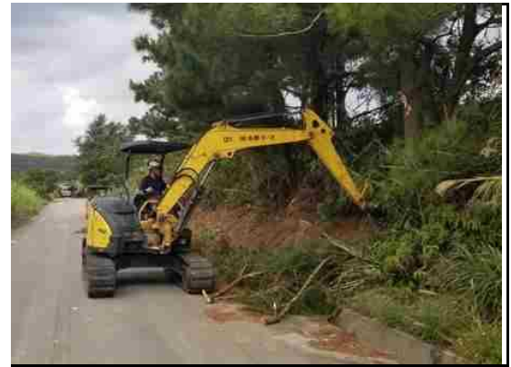
土地改良区幹線道路 ユンボで伐採
