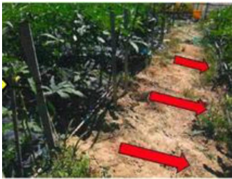
ほ場内に水が溜まらないよう排水用の溝を掘る
