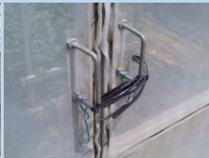
出入口の扉の固定
