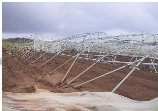
●施設の突風による倒壊
