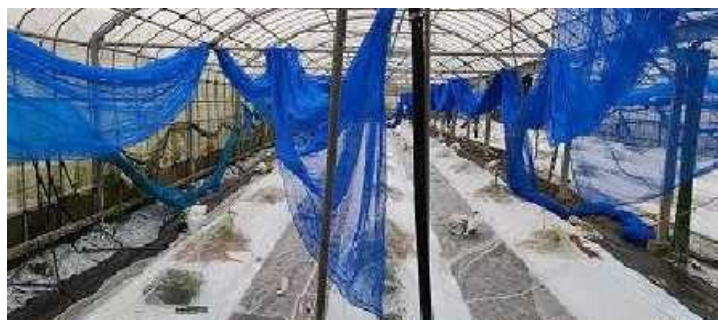
内張ネットが強風で外れ被害を受けた事例
