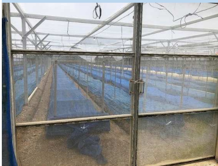
施設内の台風対策事例
