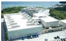
《宜野座サーパーファーム》 NTTビジネスソリューションズ クラウドサイトテクノロジー
