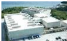
《宜野座サーバーファーム》 NTTビジネスソリューションズ コロサイトテクノロジーズ
