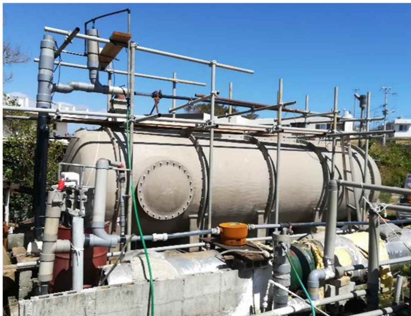
図1 10m 3 メタン発酵槽外観
