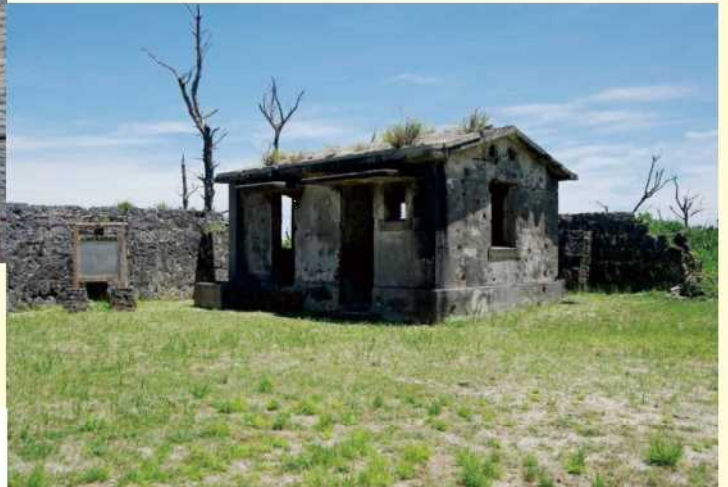
○ 元海底電線陸揚室(電信屋)(石垣市)
