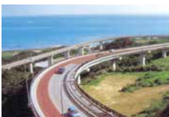
▲道路の建設や整備をしています。 南城市・ニライカナイ橋
