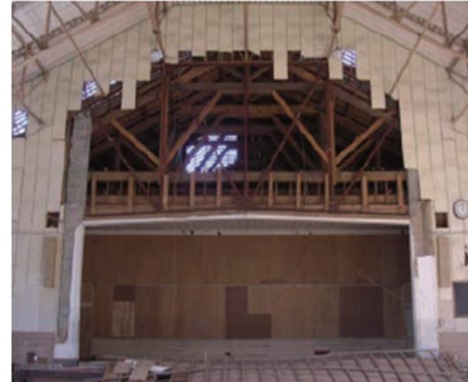
ステージ前部の壁の脱落
