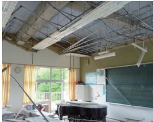
音楽室の天井材の脱落
