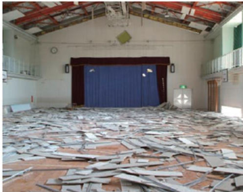
屋内運動場の天井材の脱落
