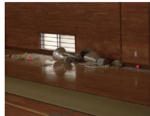
屋内運動場の照明器具の脱落
