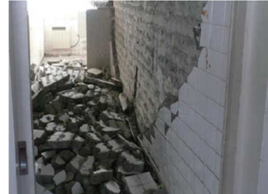
間仕切り壁の損傷
