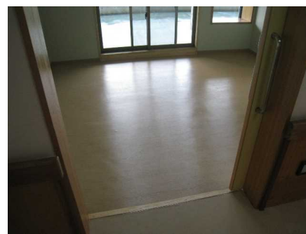
改修後 段差の無い玄関
