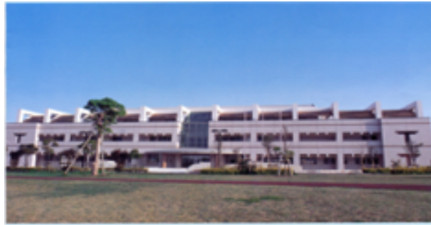
沖縄県中部保健所
