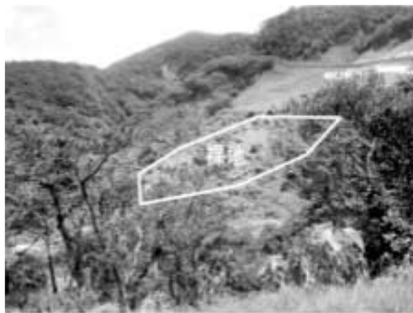
図4. 崩壊部下方の裸地
