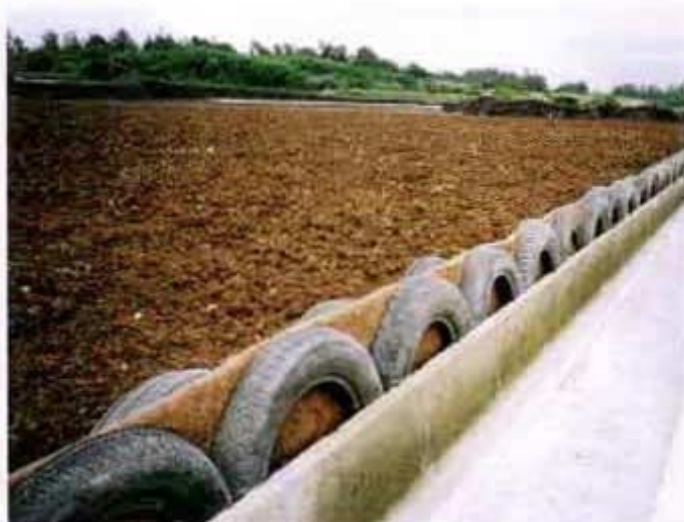
農地造成 トラクターの出入りが容易な古タイヤの畦畔工
