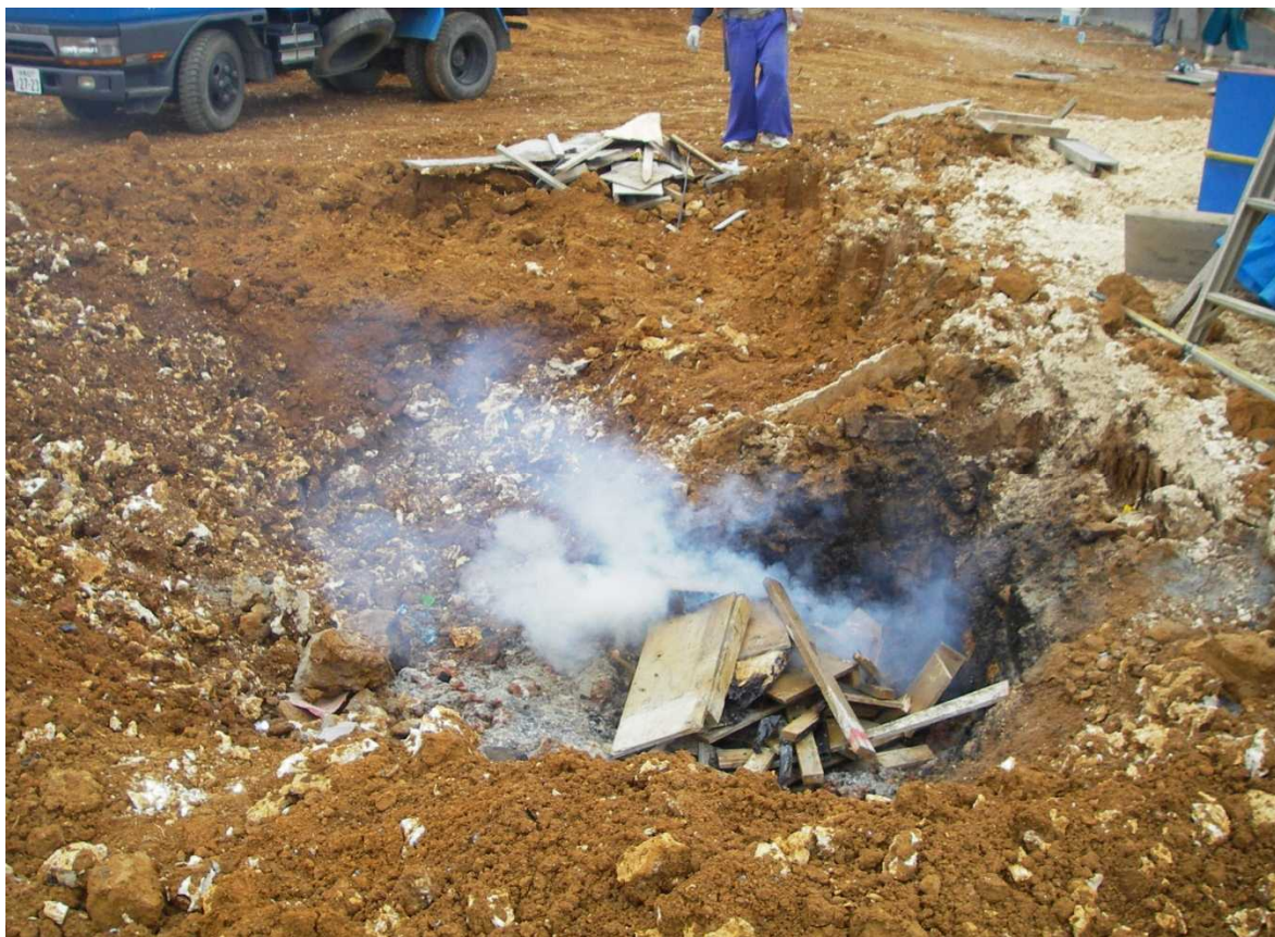
野外焼却 (建築現場)
