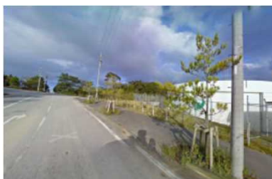
② 名護市水配水タンク
