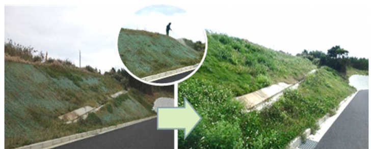
シートを撤去せずに上から直接 BSC 資材等を散布して植生を形成
