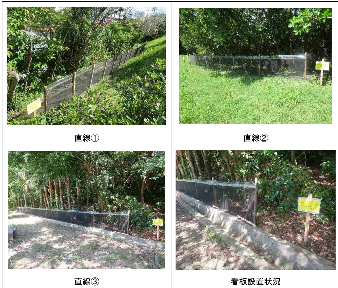
写真 3-1-6.2 直線フェンス設置
