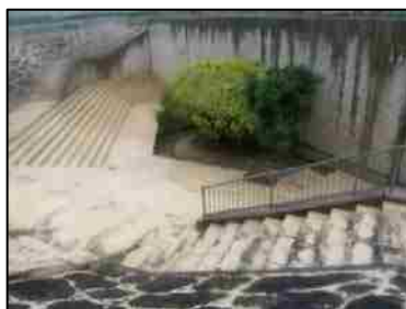
①米須地下ダム
