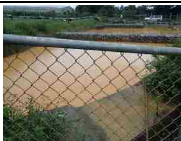
⑮ 沈砂池の状況 (オーバーフローなし)
