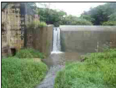
②河川中流域の砂防ダム
