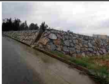
⑭ 勾配修正による赤土等の流出防止対策
