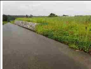
⑬ 勾配修正による赤土等の流出防止対策
