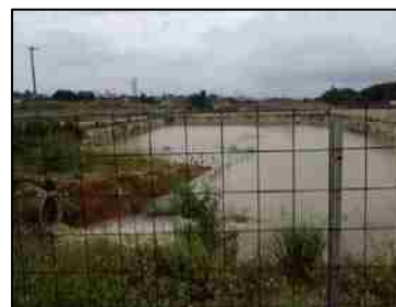
②沈砂池の造成
