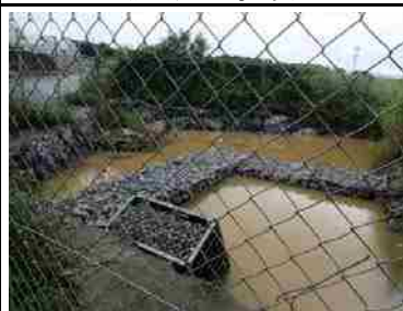
⑯ 沈砂池の状況 (オーバーフロー有り)
