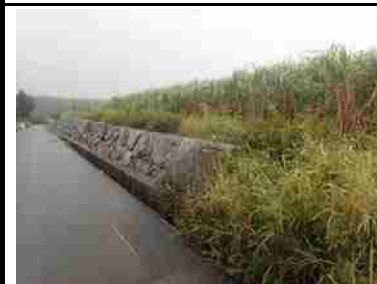
⑮ 勾配修正による赤土等の流出防止対策
