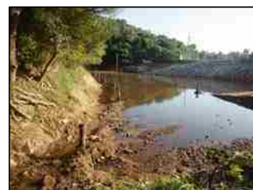
②堰(水質保全対策事業による) 平成30年度浚渫等整備済
