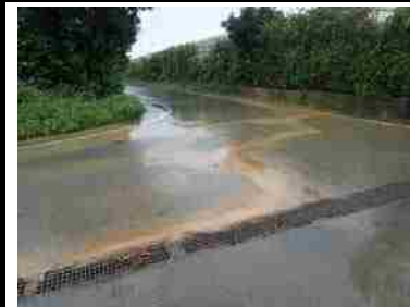
⑪ 農地から道路へ赤土等の流出状況
