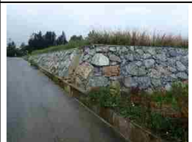
⑯ 勾配修正による赤土等の流出防止対策
