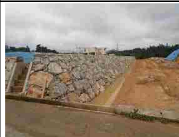
⑭ 昨年度の状況 (造成工事中)
