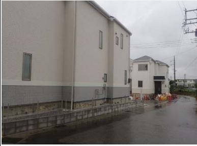
⑬ 宅地造成地の状況 (流出なし)
