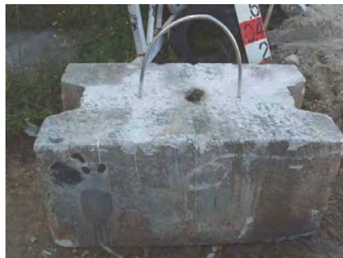
図 5-3-4. 新設アンカーブロックの構造.
