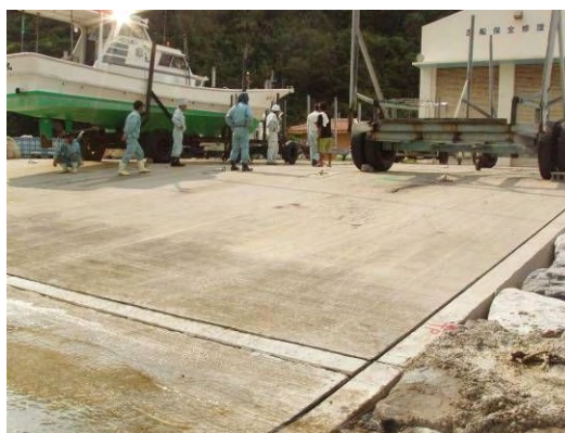
現地作業工程の調整も欠かせない協力事項
