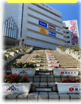
プランター設置
