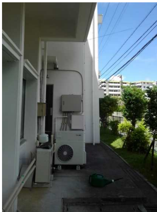
壁面のボックスは分電盤及び計測ユニット
