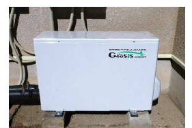
地中熱ヒートポンプ
