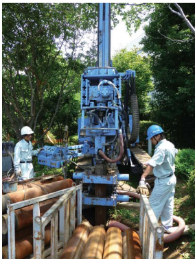
ポアホール掘削作業
