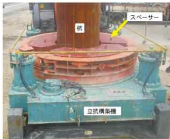
図2. 杭径変更スパーサー
