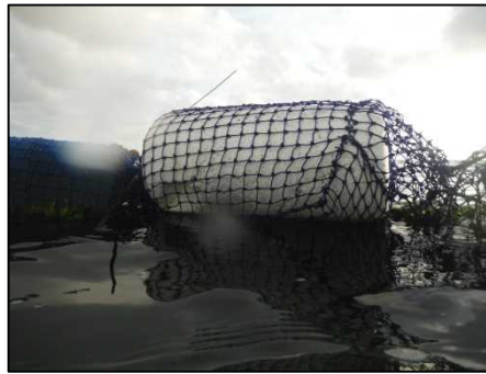
図10 追加されたフロート (図7の針金で補強されていた部分)
