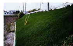
芝による法面緑化工の事例
