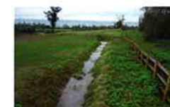
切り回し水路（水路流出抑制工）
