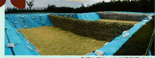
ろ過沈殿池（人工洞設置工事）
