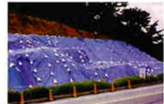
シート被覆工の事例
