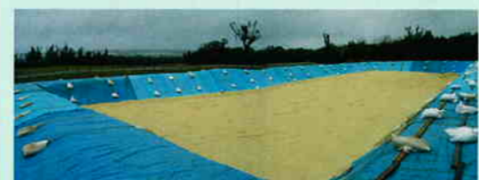
浸透池（人工洞設置工事）
