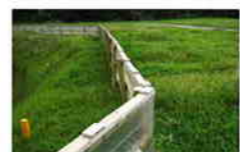
流域切り回し柵（表面流出抑制工）
