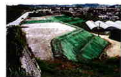
土壌団粒化剤施工の事例
