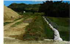
小堤工と土のう工（表面流出抑制工）
