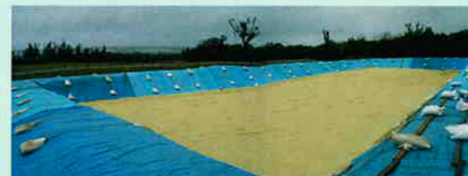
浸透池（人工洞設置工事）
