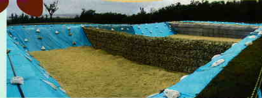
ろ過沈殿池（人工洞設置工事）
