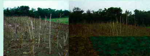
埋土種子のある表土を法面や客土に利用して、早期にかつ既存の環境に近づけて緑地の回復を図ります（グリーンベルト植栽工事）
