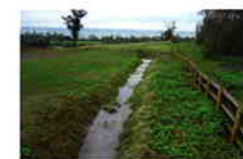
切り回し水路（水路流出抑制工）
