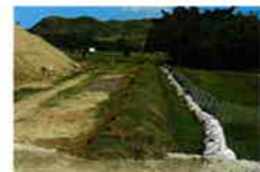
小堤工と土のう工（表面流出抑制工）
