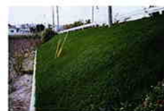
芝による法面緑化工の事例
