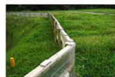
流域切り回し柵（表面流出抑制工）
