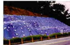
シート被覆工の事例
