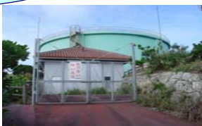
②各地区への配水施設（ファームポンド）
