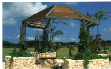
石垣島サッカーパークの休憩施設（パーゴラ）
