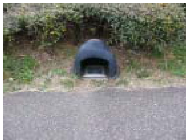
照明は光が漏れないよう工夫
