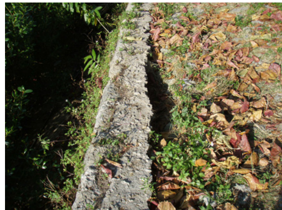
天端被覆工における沈下・陥没事例
