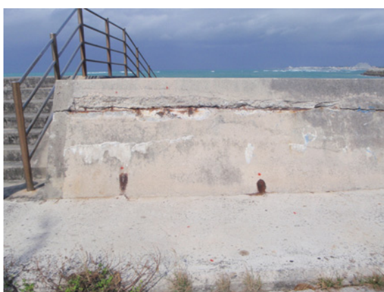
鉄筋の腐食
