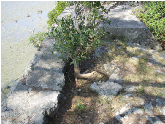
天端被覆工における沈下・陥没事例
