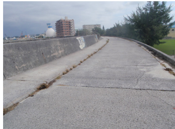
天端被覆工の事例
