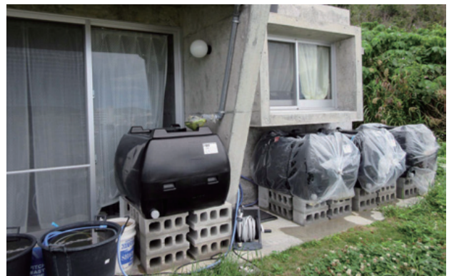
屋上緑化雨水循環システム
