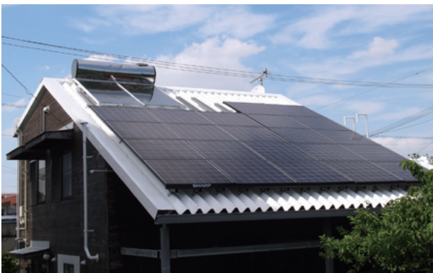
太陽熱温水器と太陽光発電システム
