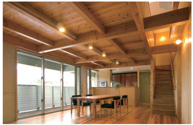
鉄筋コンクリート造のスケルトンに木造のインフィルを組み合わせてある
