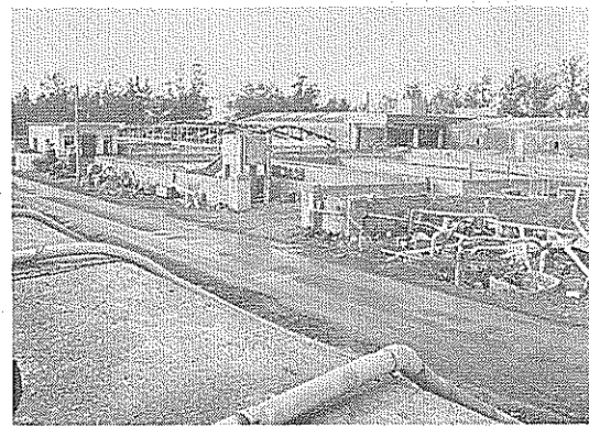
護岸の上から配管し、池まで取水している
