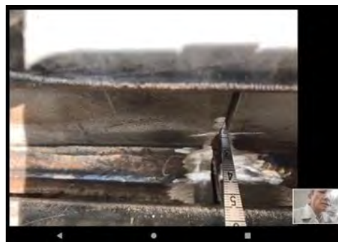
【継手部隙間測定】 目盛に寄れば確認可能
