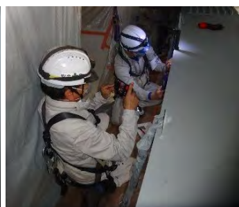
【測定箇所に照明を設置】
