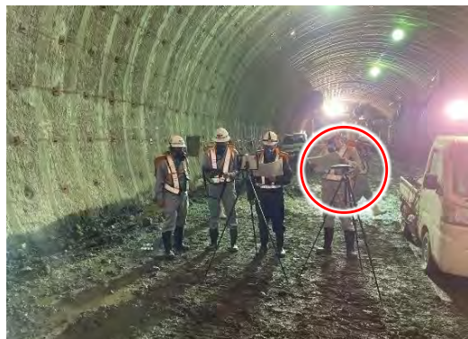
【会議用スピーカーの設置（現場側）】
