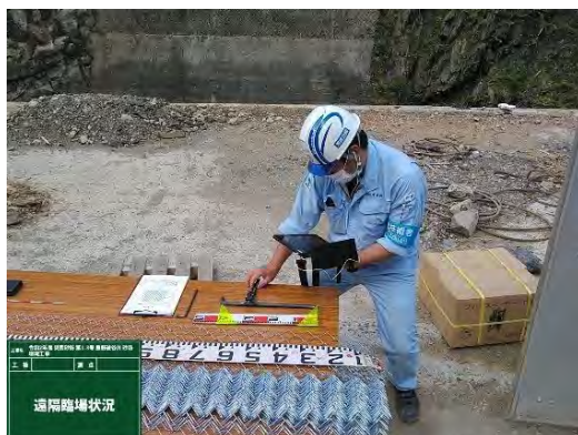
【立会状況（現場側）】
