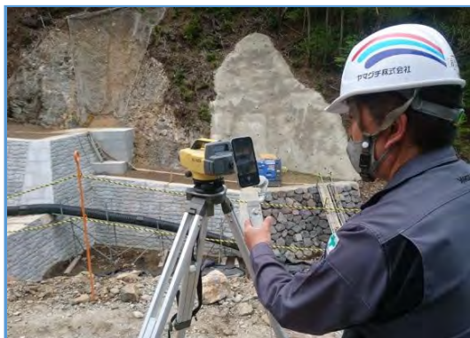
【立会状況（現場側）】
