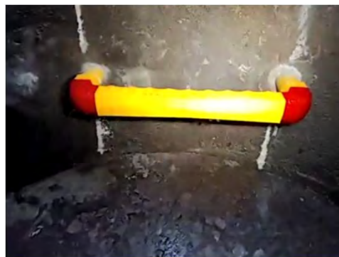
【オンライン検査（足掛金物取付確認）】
