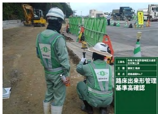
【工夫が分かる写真 (杭打ちアプリ)】
