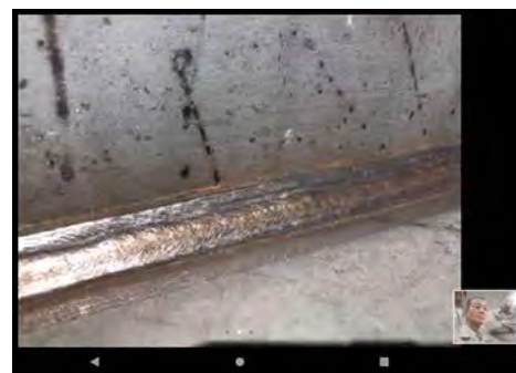
【溶接の仕上がり】 静止して寄れば確認可能だが 移動しながらの確認は映像では難しい
