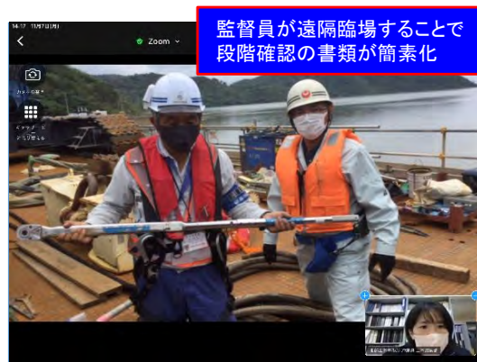
【現場技術業務の現場立会に監督員が遠隔臨場】
