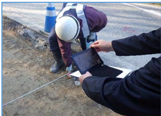
【立会状況（現場側）】
