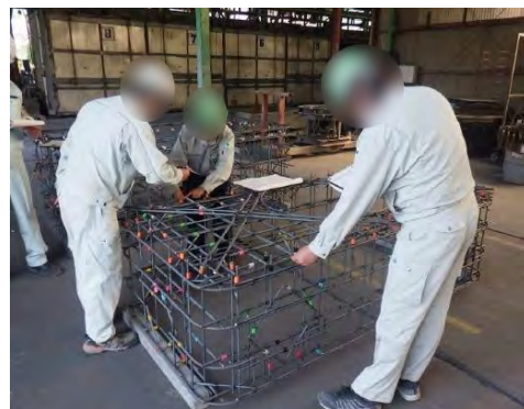
【現地状況（特殊部配筋）】
