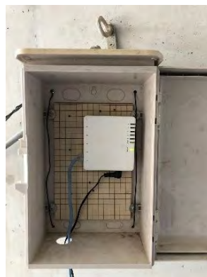
【坑内にWi-Fiルーターの設置(@100m)】
