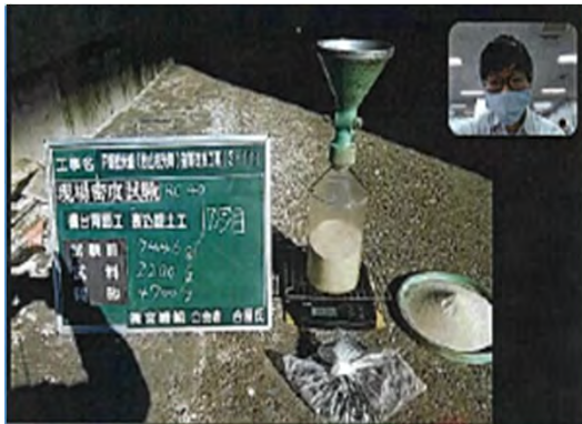
【立会状況（現場側）現場密度試験】
