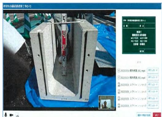
【横断側溝材料検収】
