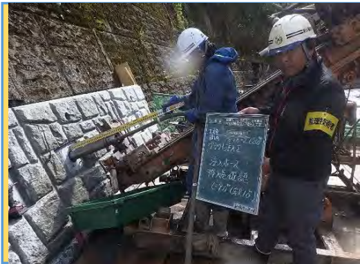
【立会状況(施工状況)】
