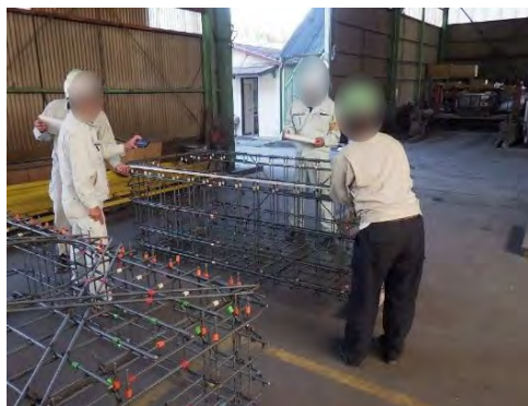
【立会状況（特殊部配筋）】
