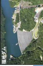
沖縄で最大容量を誇るダム 型式: ロックフィルダム 堤高: 91.7m 堤頂長: 260m 総貯水容量:55,000,000m3
