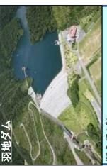
堤高: 66.5m 堤頂長: 198m 総貯水容量:19,800,000m3 型式:ロックフィルダム
