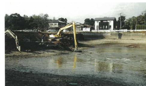
<ため池の浚渫工事>
