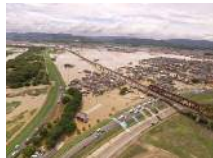
岡山県倉敷市真備町
