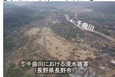
【令和元年東日本台風】
