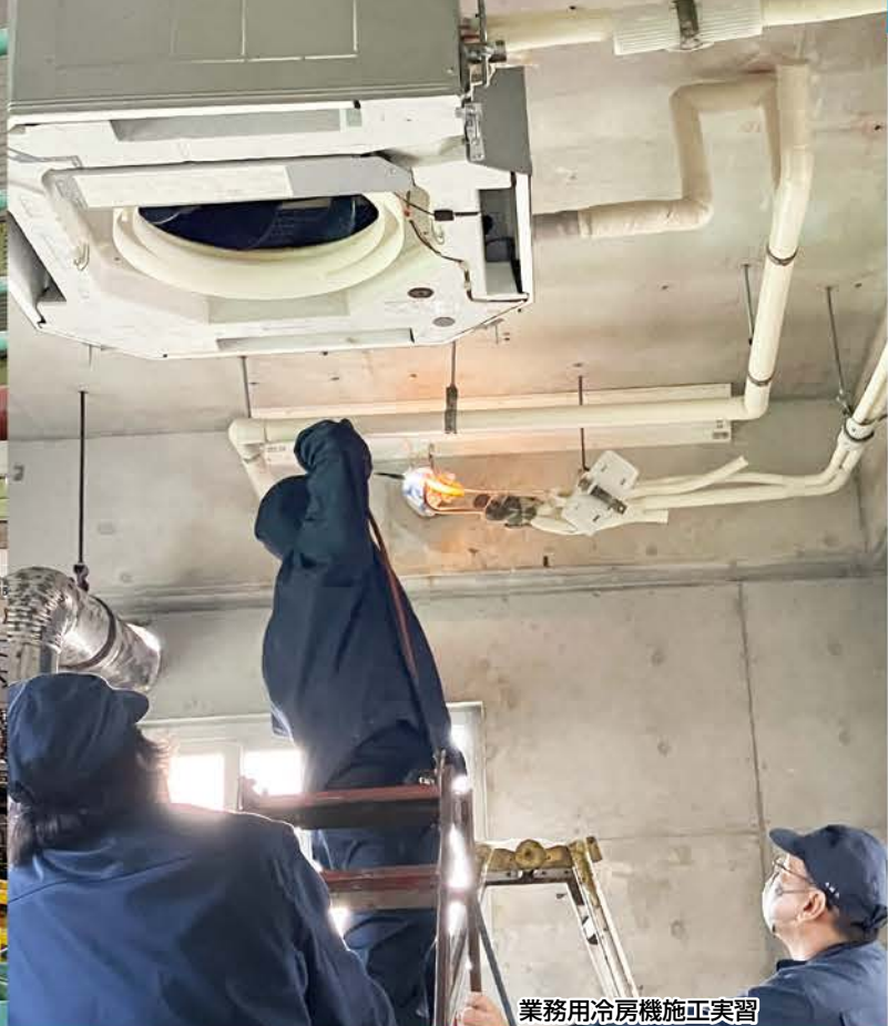
衛生設備施工実習
