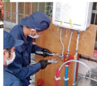
ガス設備施工実習
