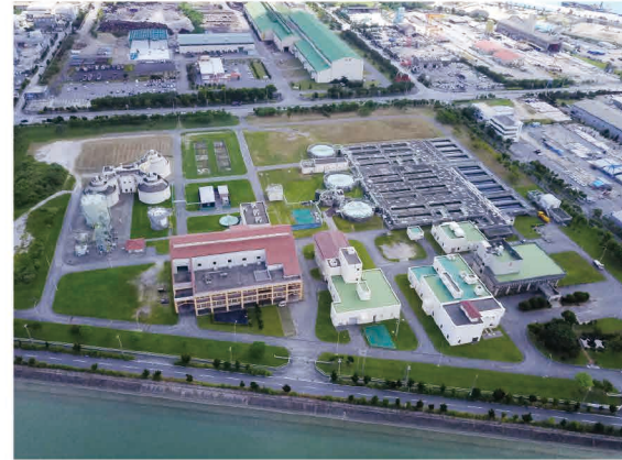
具志川浄化センター(みずクリン具志川)
