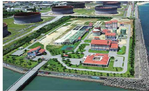
西原浄化センター(みずクリン西原)
