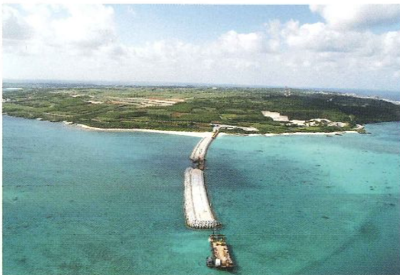
伊良部島側進捗状況(平成20年11月)
