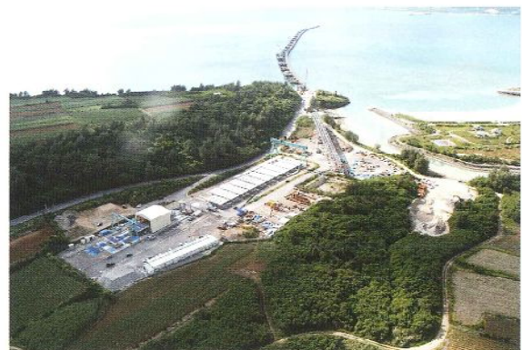
宮古島側進捗状況(平成20年11月)
