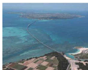
いらぶ 伊良部大橋 ㉑
