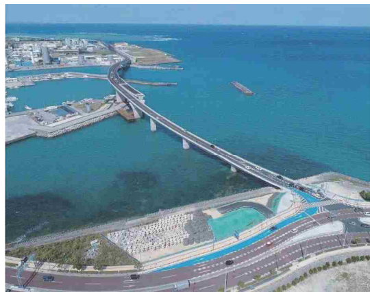
国道58号 浦添北道路
