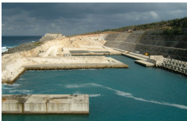
図2 南大東漁港工事外観
