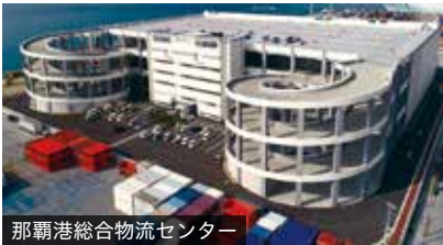
那覇港総合物流センター
