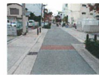
ハンプ設置状況
