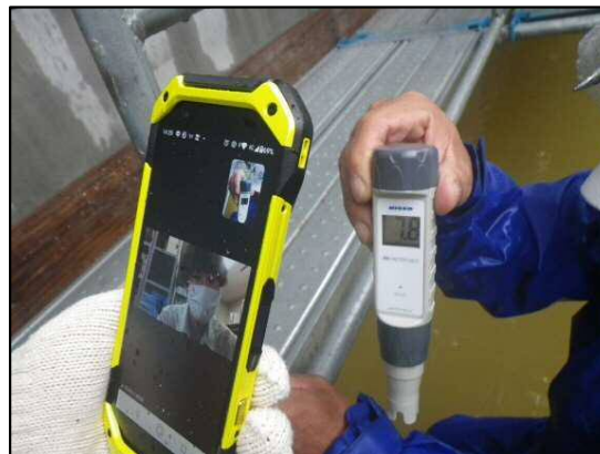
【監督員からの指示により接写した様子】
