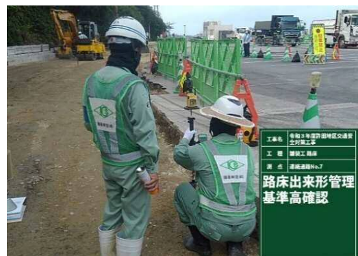
【工夫が分かる写真 (杭打ちアプリ)】
