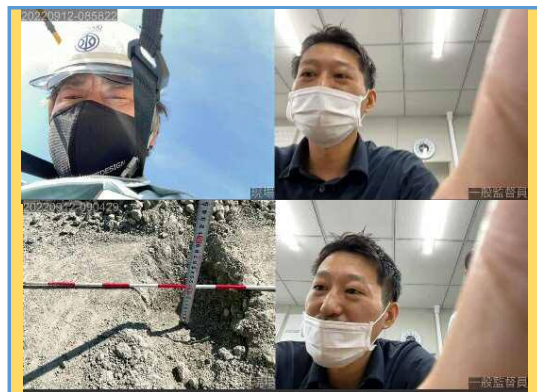
【立会状況 (監督側)】
